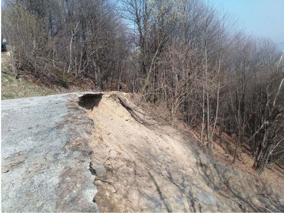
Foto 2: Accesso strada comunale Borgata Garzini
