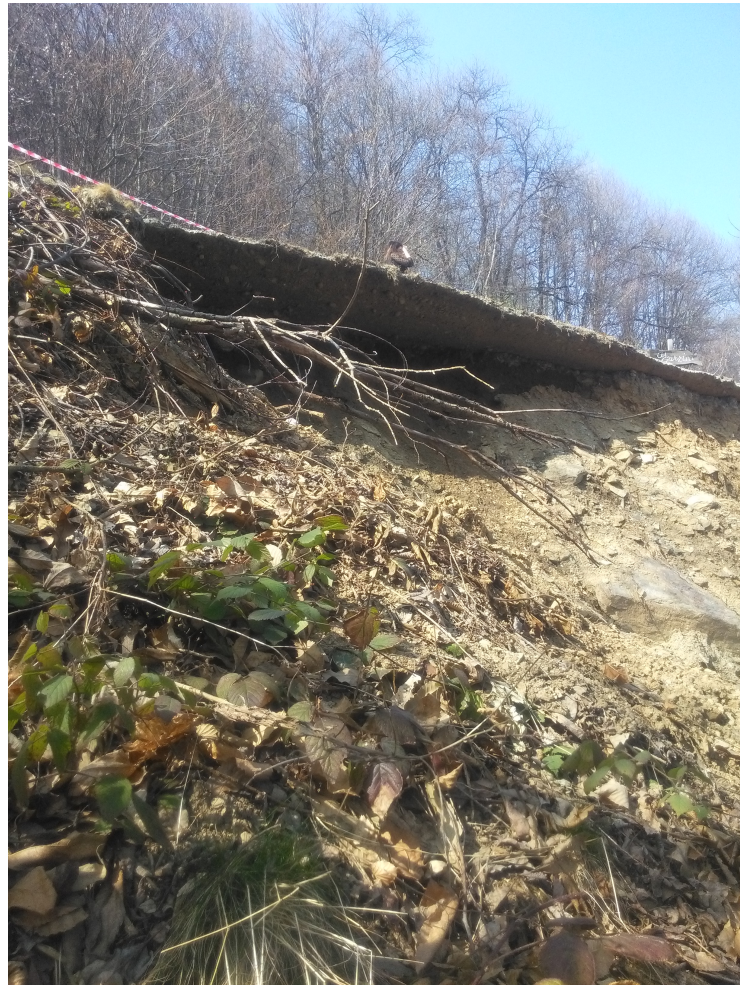
Foto 3: Vista da valle verso strada comunale
