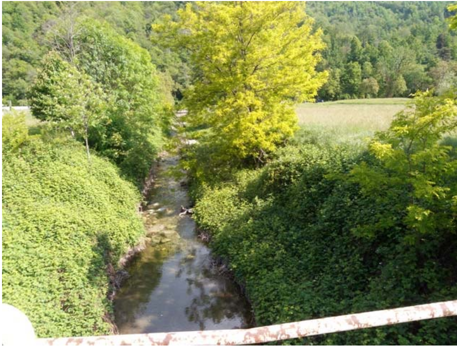
Figura 5: alveo dello scolmatore a valle dell'attraversamento della Provinciale.
