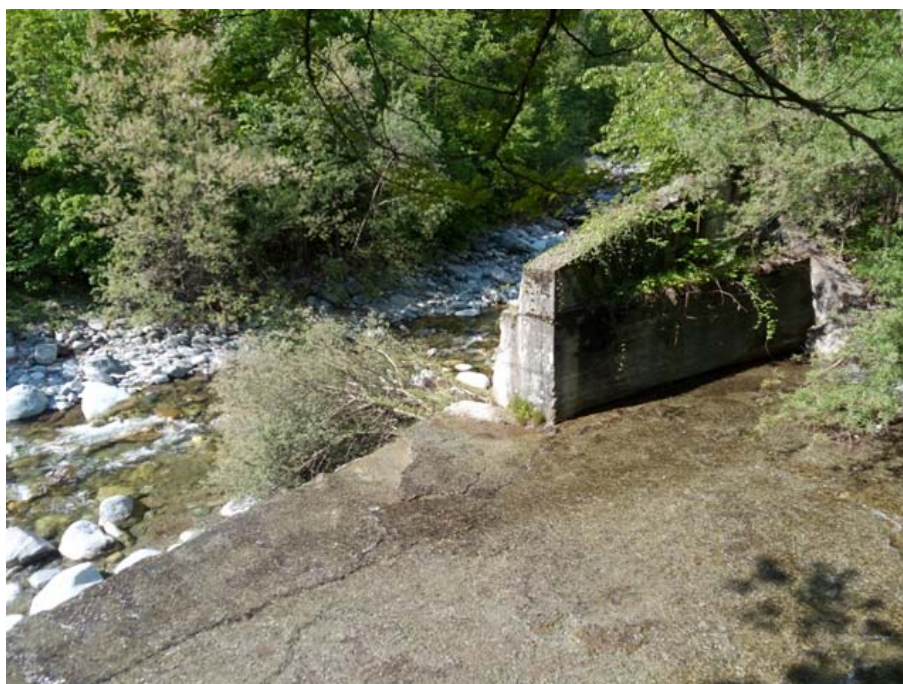
Figura 7: manufatto in c.a. di scarico dello scolmatore nel Fiume Po.
