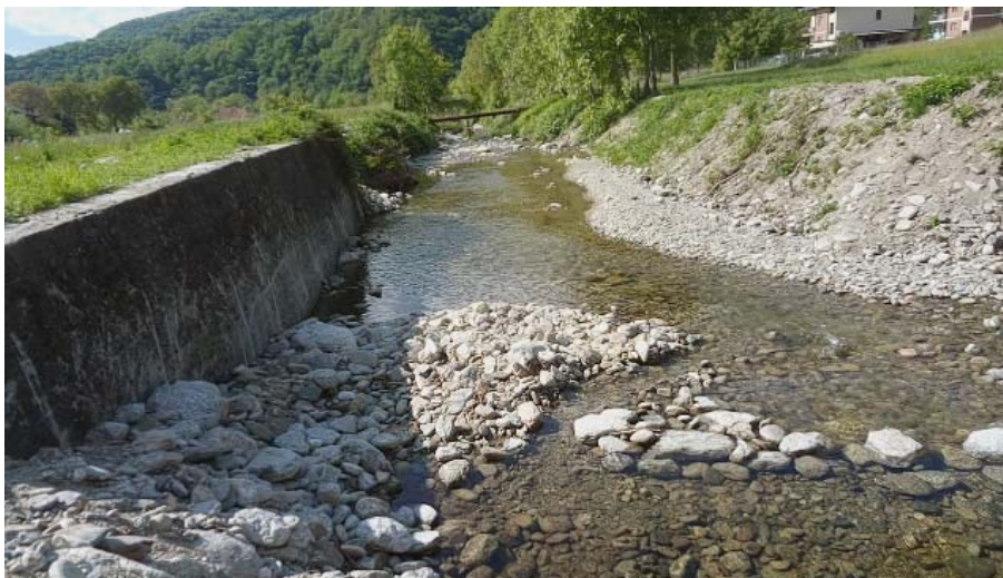
Figura 4: alveo del canale scolmatore nel tratto iniziale.
